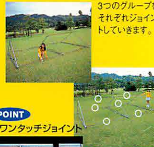
屋根の骨組の完成
