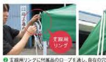
② 支線用リングに付属品のロープを通し、自在の穴に通します。
