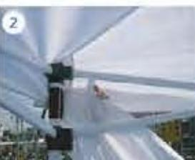
支柱のマジックテープと横幕のマジックテープを貼り合せ、杭のサイドクロスフレームには巻き留めます。
